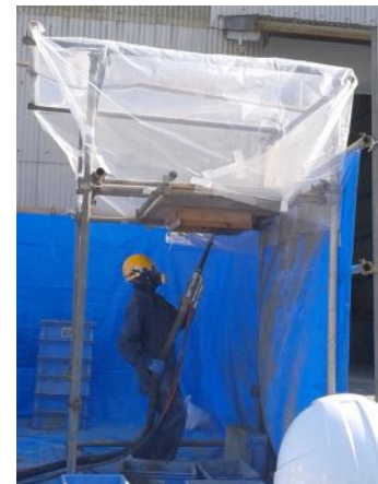
「クロルフィックスショット」施工状況(t=50mm)
