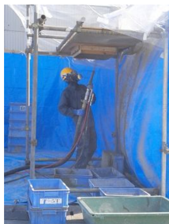
「クロルフィックスショット」施工状況(t=50mm)
