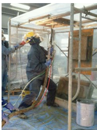
(クロルフィックスショット施工デモ)
